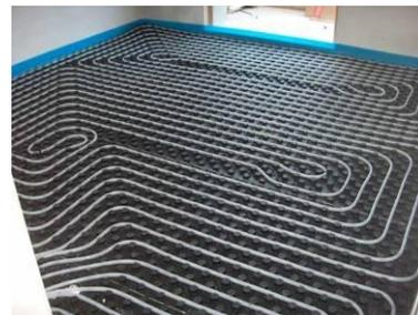
L' impianto è principalmente costituito da collettori di distribuzione con testine elettriche (il numero di circuiti aperti determina la modulazione dell' inverter delle pompe di circolazione dell' impianto di riscaldamento/raffrescamento) inseriti in cassette a muro, pannelli sagomati posati sottopavimento e una serie di circuiti chiusi con tubazioni in materiale composito all' interno delle quali scorre l' acqua calda/refrigerata prodotta dalle pompe di calore.
