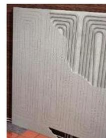
Nei servizi igienici verrà installato un sistema radiante a parete, posizionati sopra i sanitari. Tale sistema è composto da pannelli in gesso rivestito al cui interno è annegata una tubazione collegata al collettore di distribuzione dell' impianto radiante. Questo sistema garantisce l' ulteriore apporto termico richiesto nei locali adibiti a servizi igienici.
